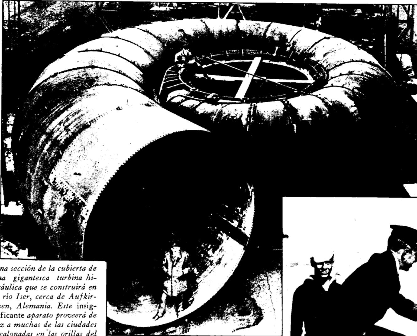
Una sección de la cubierta de una gigantesca turbina hidráulica que se construirá en el río Iser, cerca de Aufkirchen, Alemania. Este insignificante aparato proveerá de luz a muchas de las ciudades escalonadas en las orillas del Iser.
